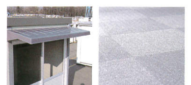
FRP製ひさし タイルカーペット
