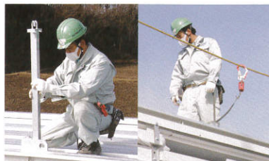
安全を確保した屋根上作業
