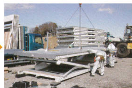
② 吊り上げ
