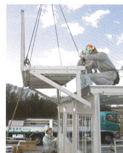
1階屋根部分から歩廊を設置
