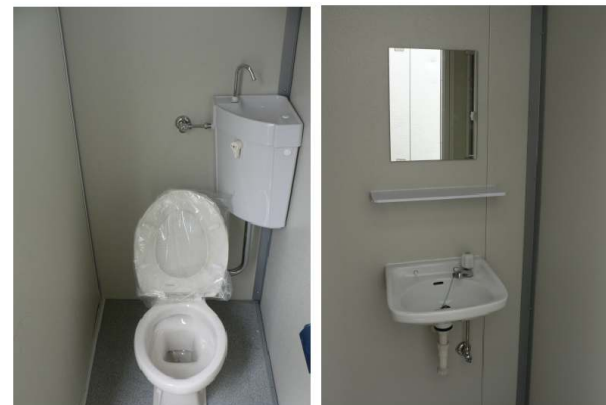
トイレBOX室内
