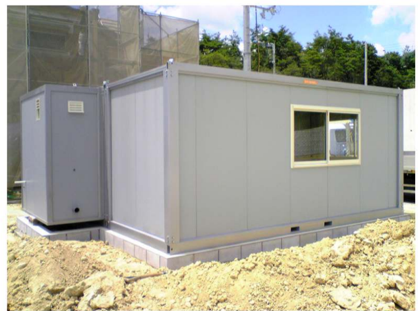
トイレBOX外観
